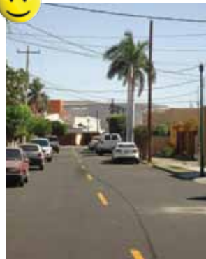
Mantenimiento a las calles de la ciudad.
